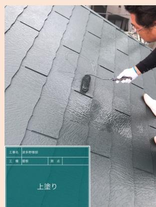
「スレート」や「コロニアル」と言われる屋根は、築10年位で表面が劣化してきます。茶色く変色しだしている屋根の場合、20～50箇所程、割れたり欠けたりしている事がほとんどです。塗装をすることによって屋根の耐久性を復活させる事ができます。最近では、屋根表面の熱を下げる「遮熱塗料」が人気です。
