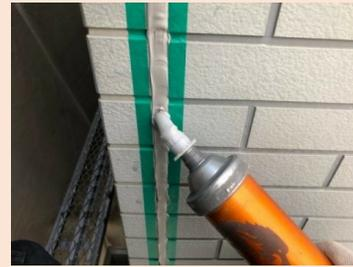
**シール工事とは、空気・水などのもれを防ぐ【密封・密閉】という意味です。サイディングパネル板の継ぎ目を密封して水漏れを防ぐ工事**
